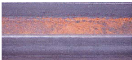
Ocelový nosník - před
