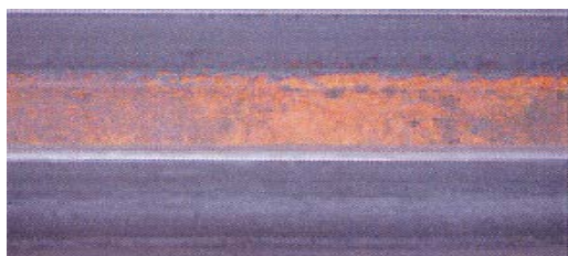
Poutre en acier - avant
