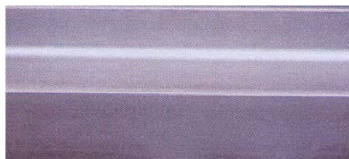
Poutre en acier - après
